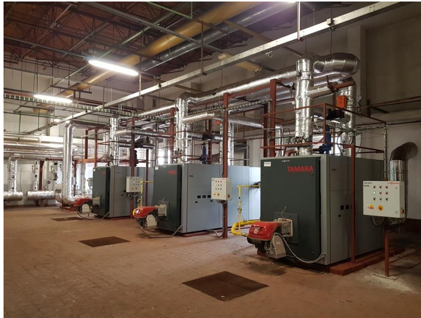
Plynová kotelna (náhrada původní parní kotelny) 3x 1600 kW nízkoteplotní kotel
